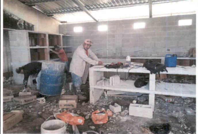
REMODELACIÓN DE COCINA
