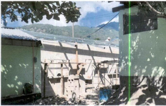
REMODELACIÓN DE COCINA
